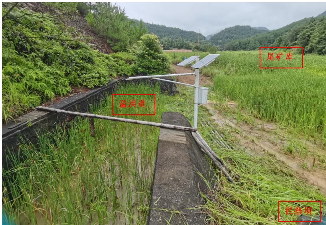
图 2-3 尾矿库现状图（坝上看向库尾）
