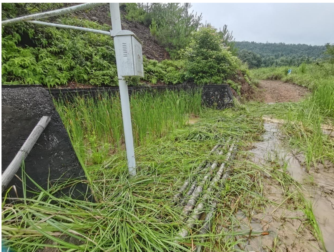
图 2-9 溢洪道进水侧槽
