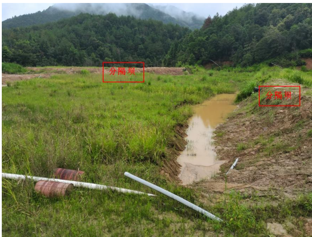
图 2-4 尾矿库库内分隔坝
