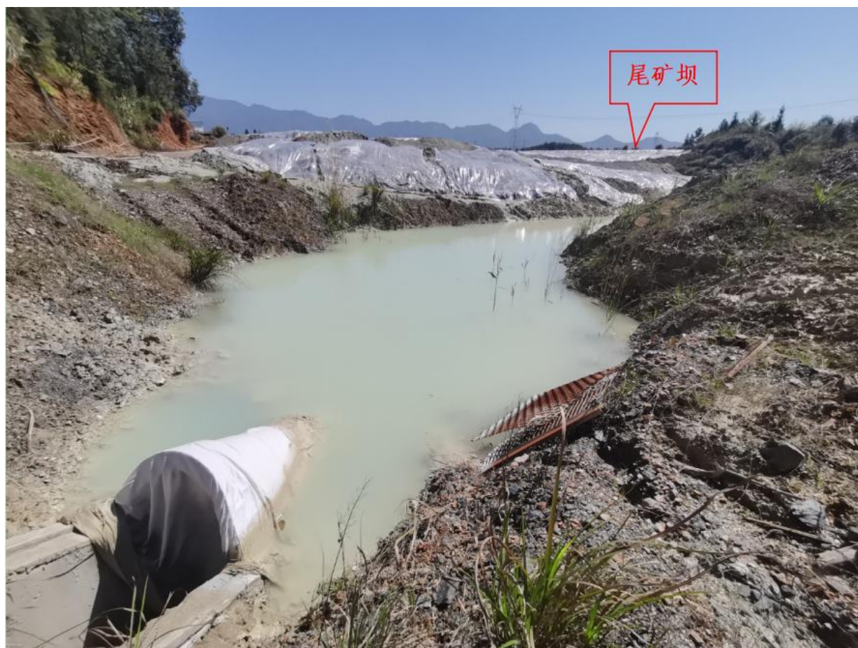
图 2-3 尾矿库闭库前现状图（库尾看向尾矿坝）
