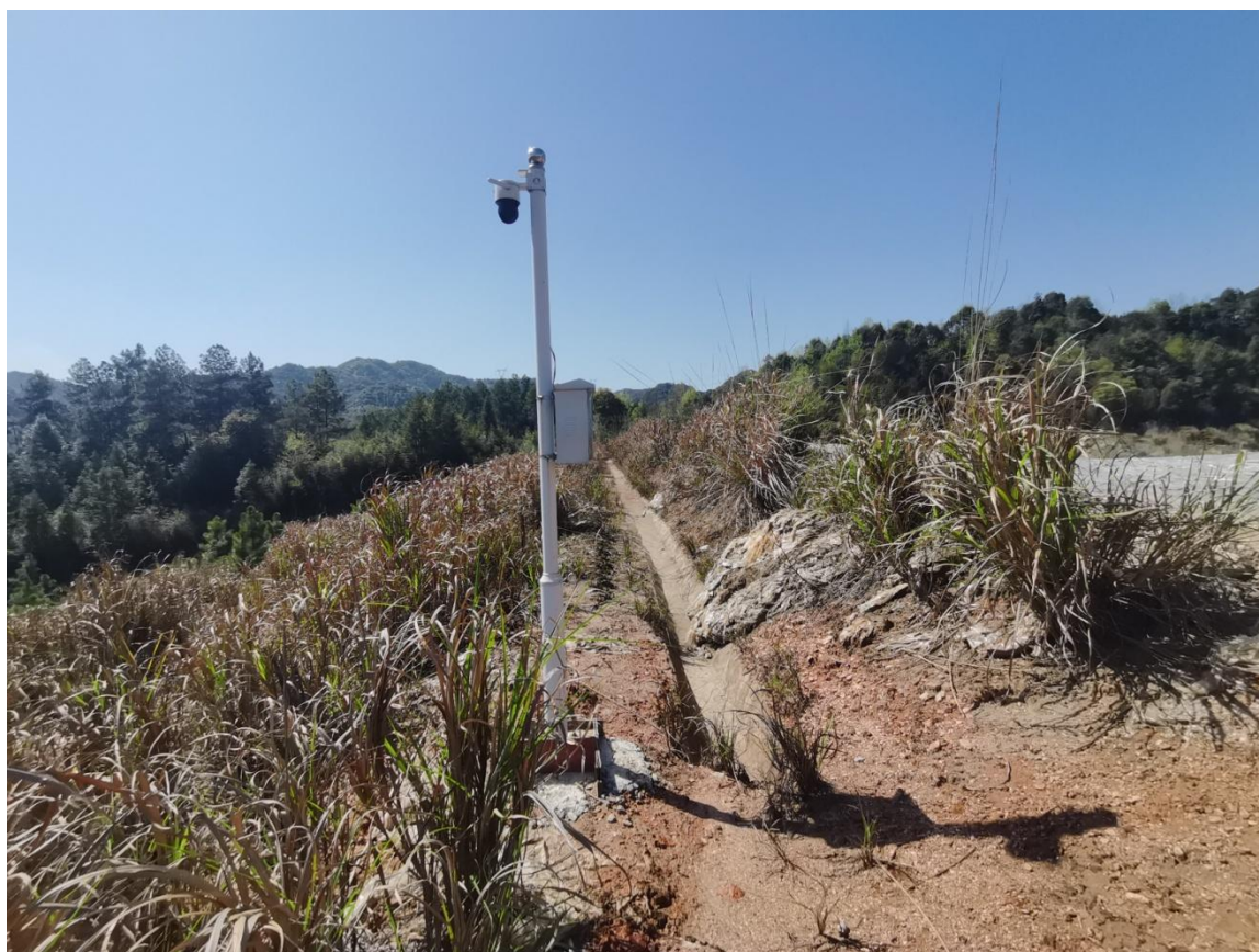
图 2-5 堆积坝下游坝坡
