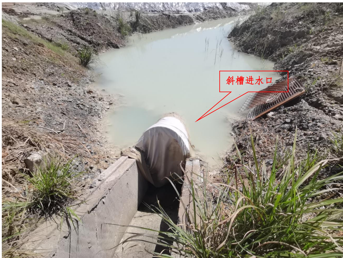
图 2-6 斜槽进水口
