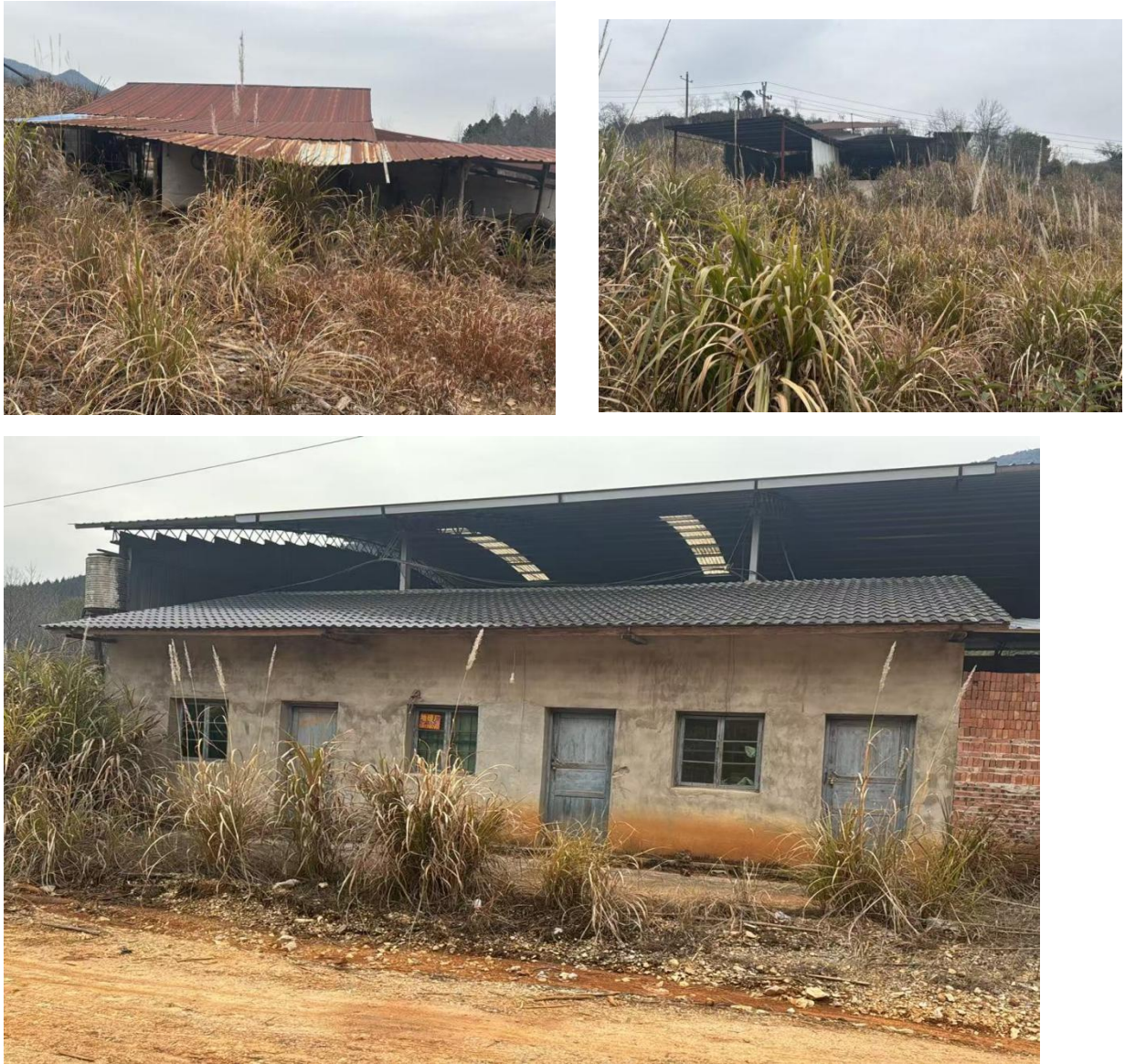
图 2-3 东侧废弃建筑照片
