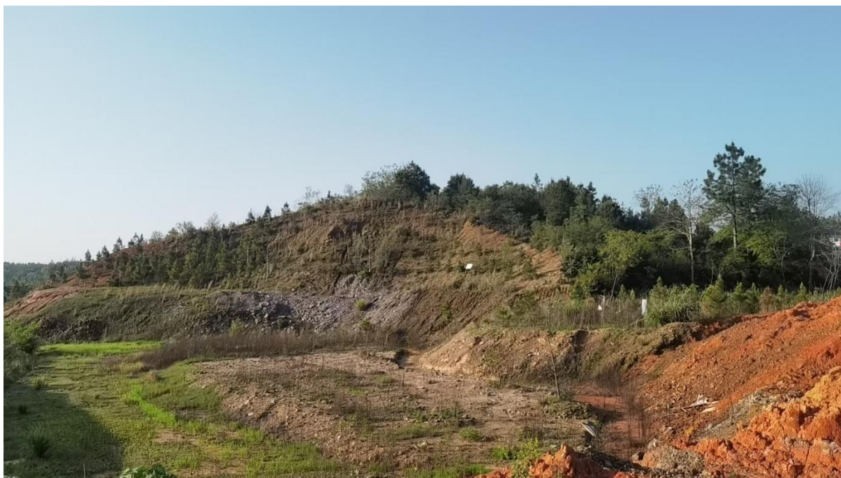
图 2-2 北侧现状边坡
