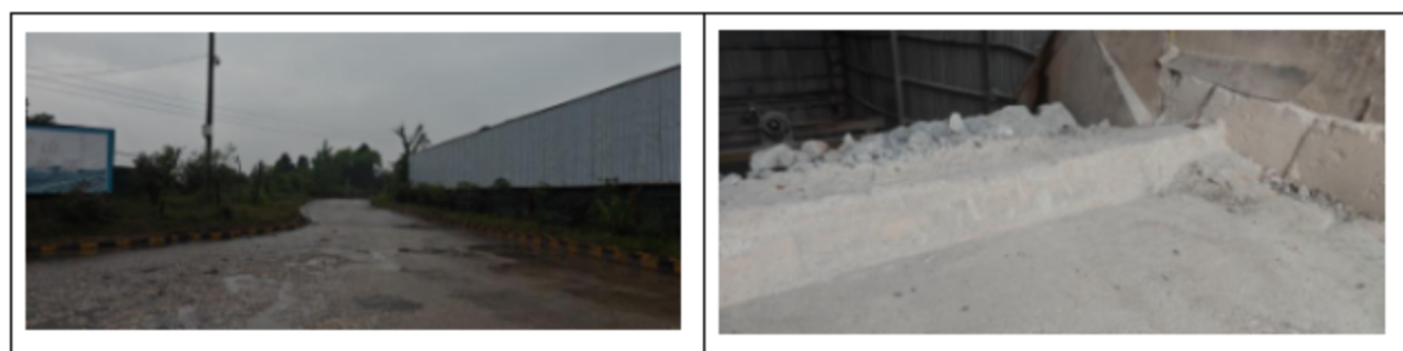
图 2.5-5 矿区运输道路及卸矿口安全车挡
