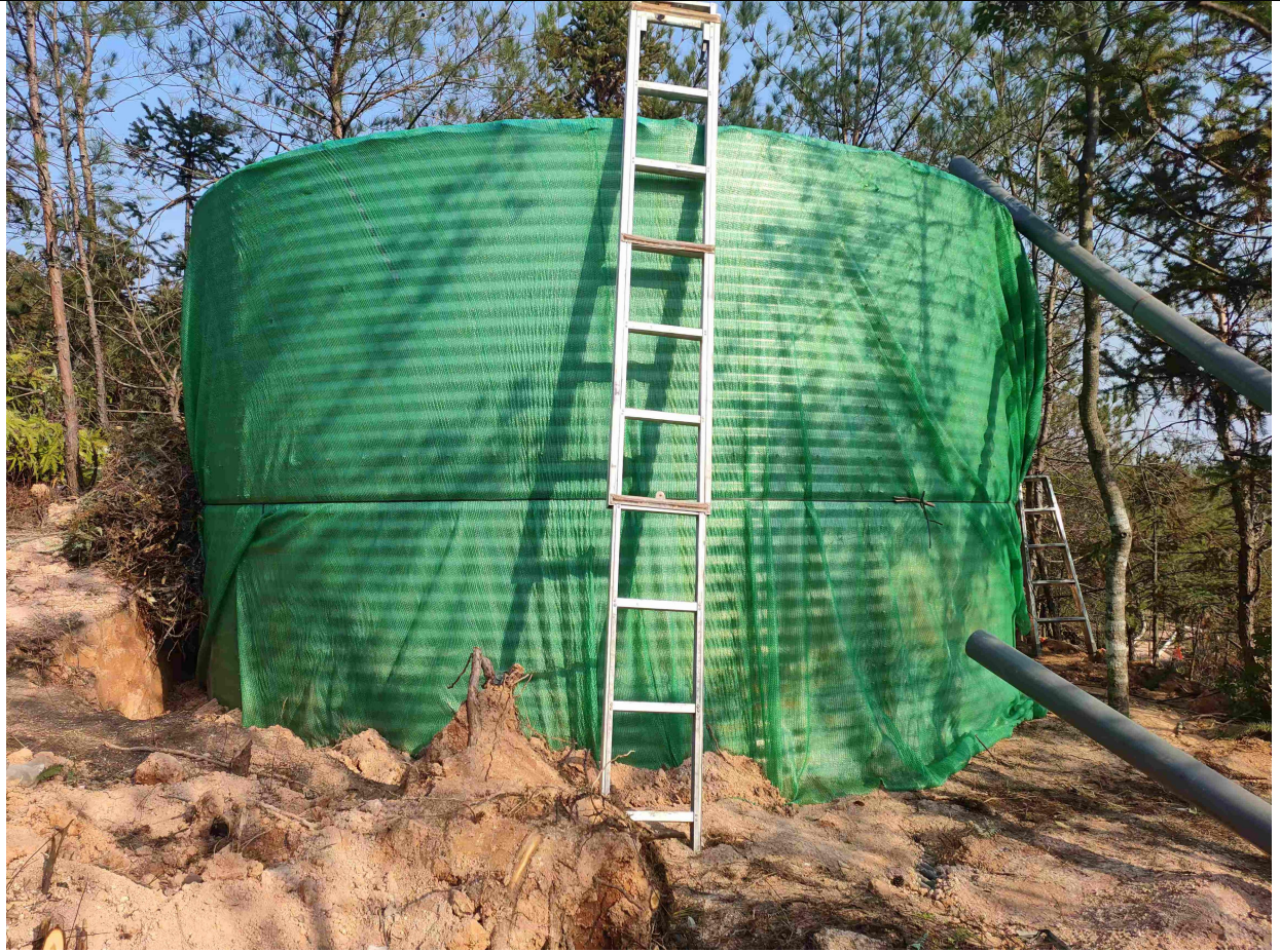
高位池、浸矿剂中转池
