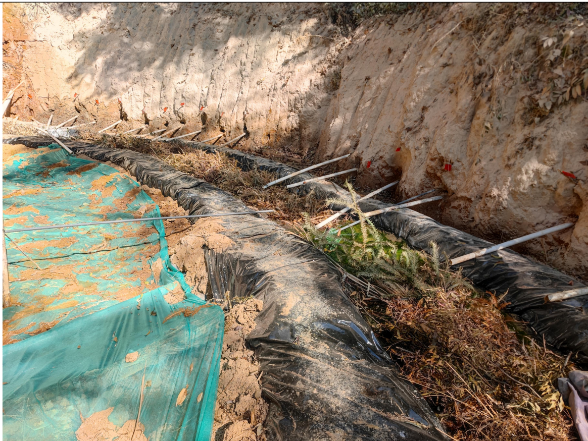
集液沟及千米钻出口
