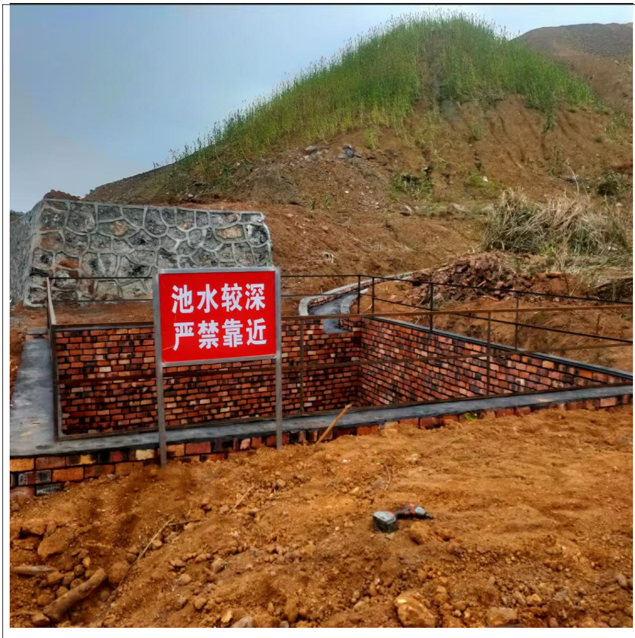
图6 沉淀池现状实拍图
