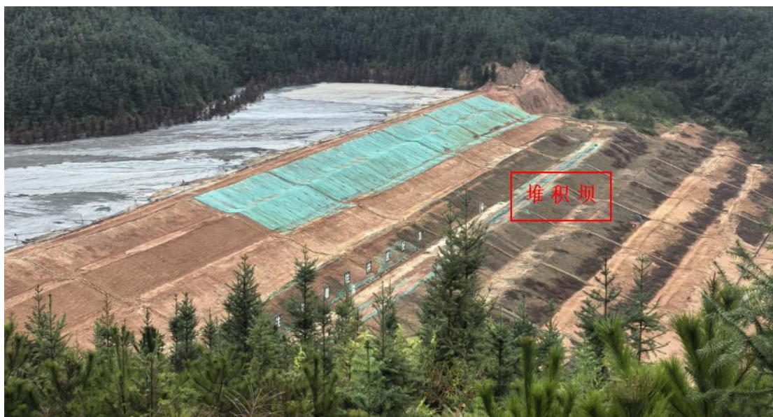
图 2-3 堆积坝下游坝坡
