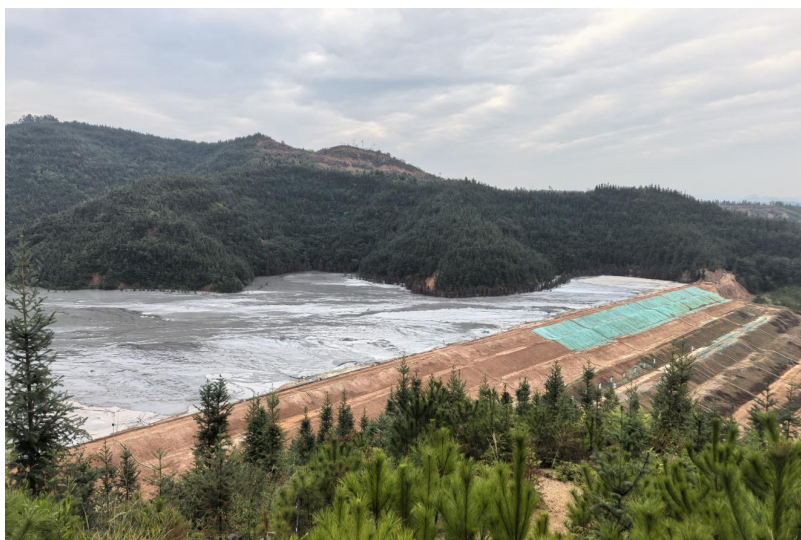
图 2-1 尾矿库现状（坝顶看向库内）
