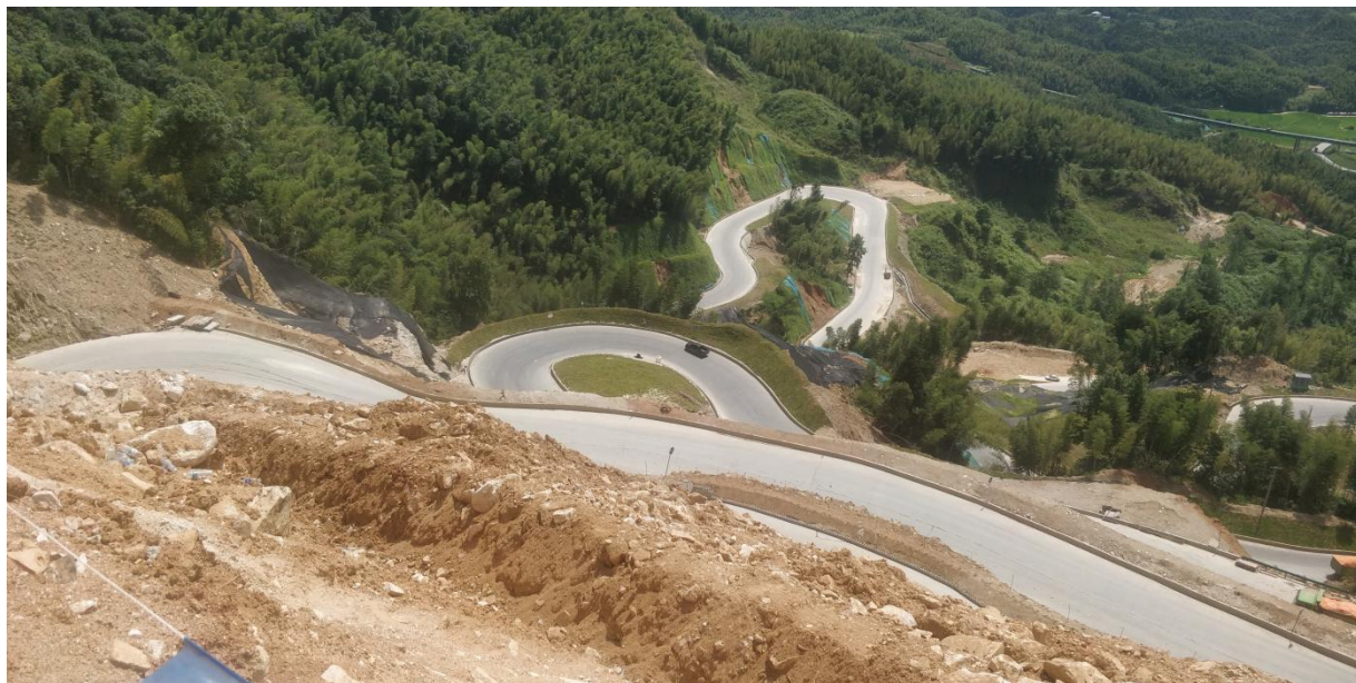
图 2.4-3 矿区运输道路
