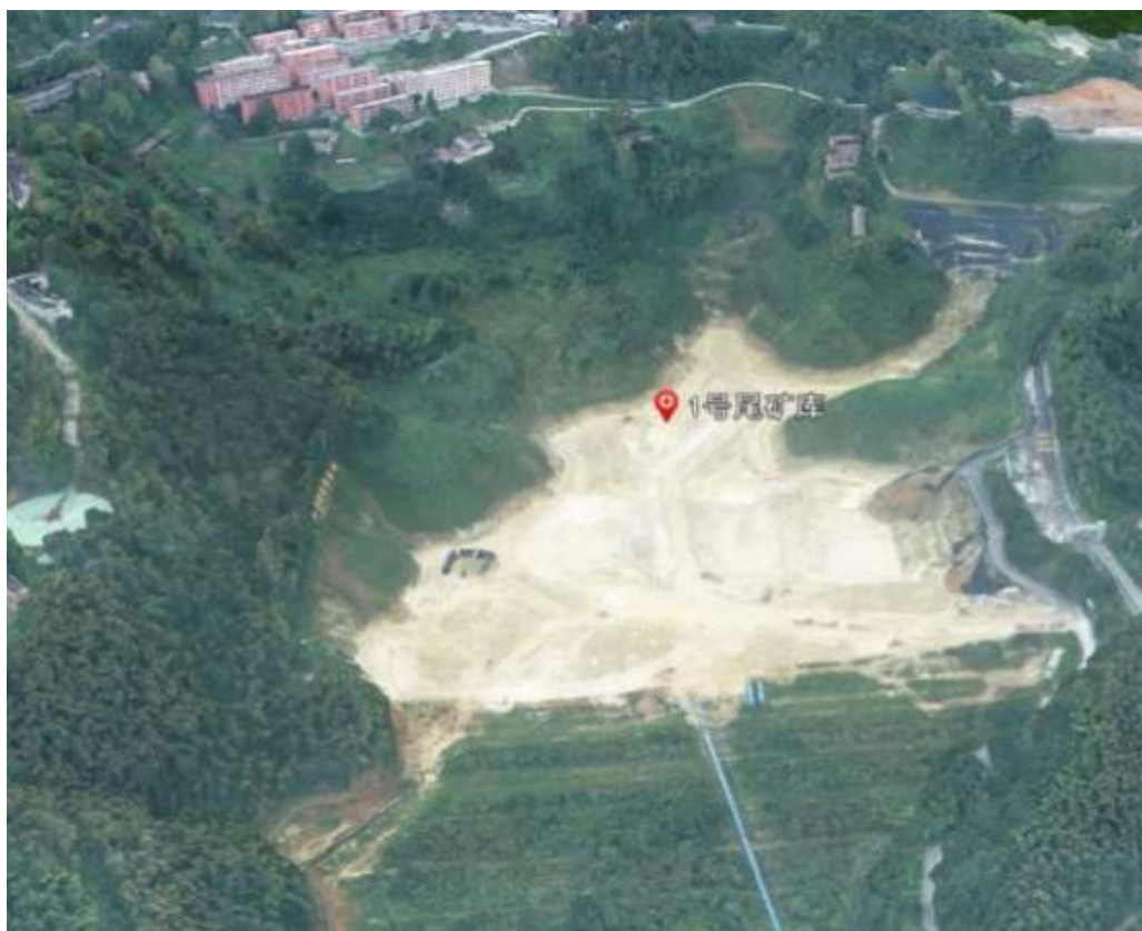
图 2-2 3 号尾矿库库址
