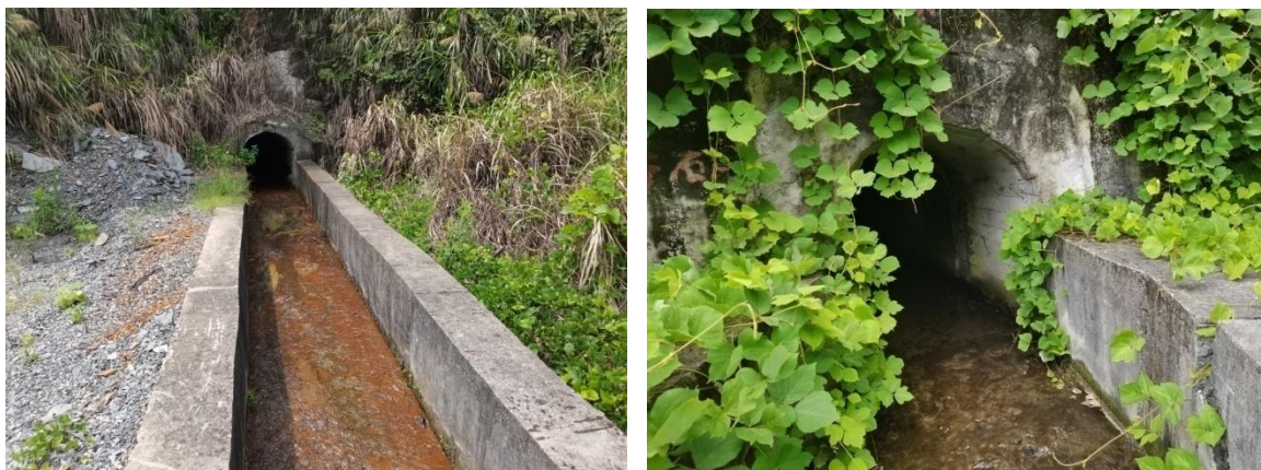
图 2-10 1 号隧洞与 2 号隧洞出口
