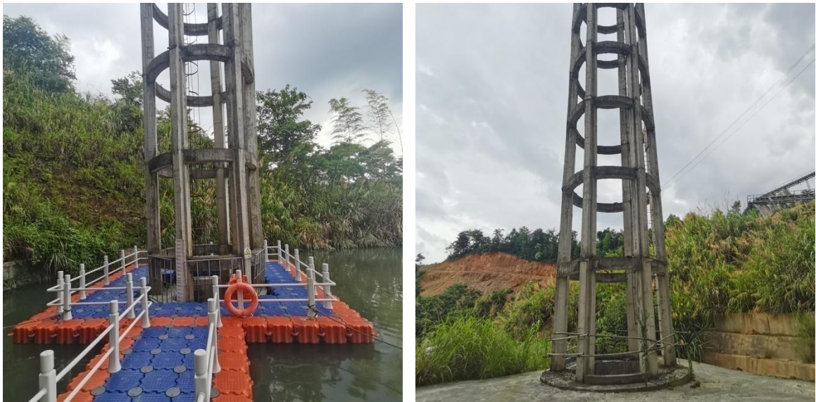
图 2-8 2号排水井和3号排水井
