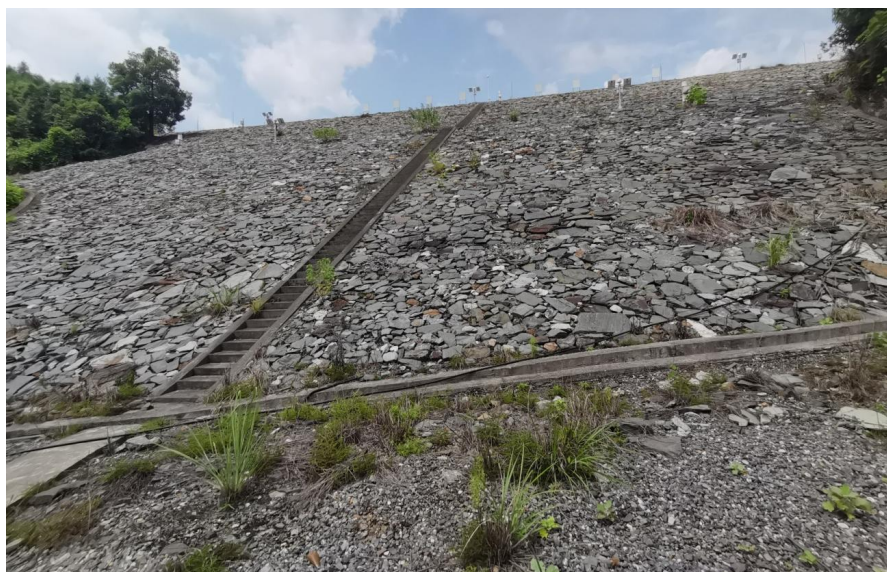
图 2-3 尾矿库初期坝下游坡面
