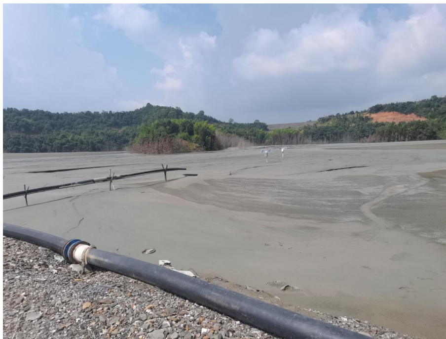
图 2-2 尾矿库（坝顶看向库尾）
