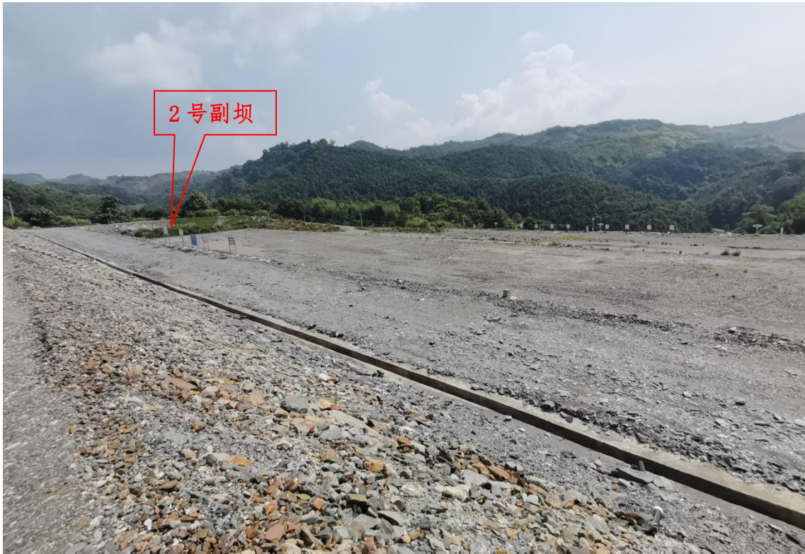
图 2-5 尾矿库堆积坝下游（坝顶看向左坝肩）
