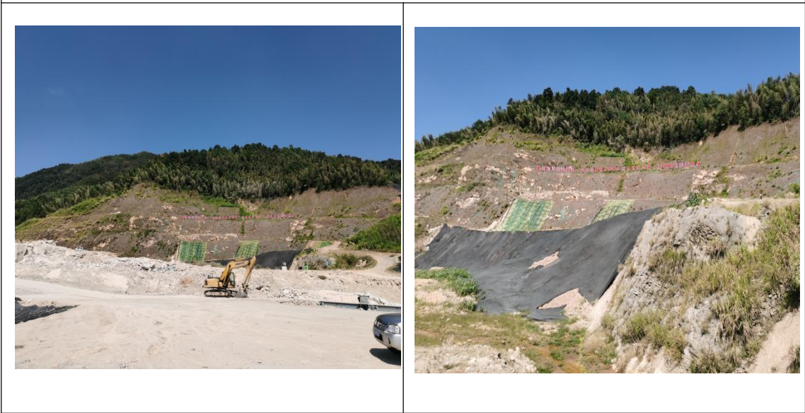
图 2.3-4 人工切坡 QP4 现状图
