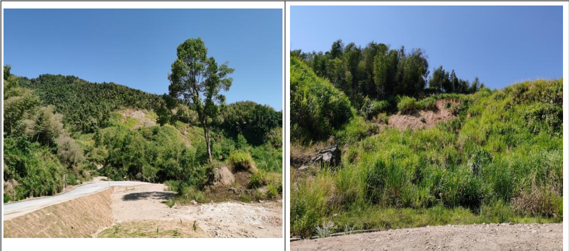
图 2.3-3 人工切坡 QP3 现状图
