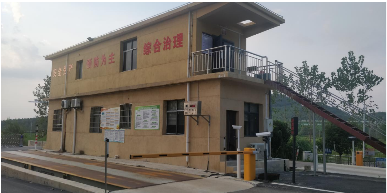
图 2.6-2 矿山磅房及值班室
