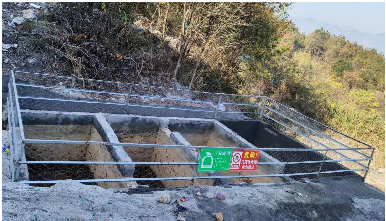
图 2.4-3 排土场新建沉淀池
