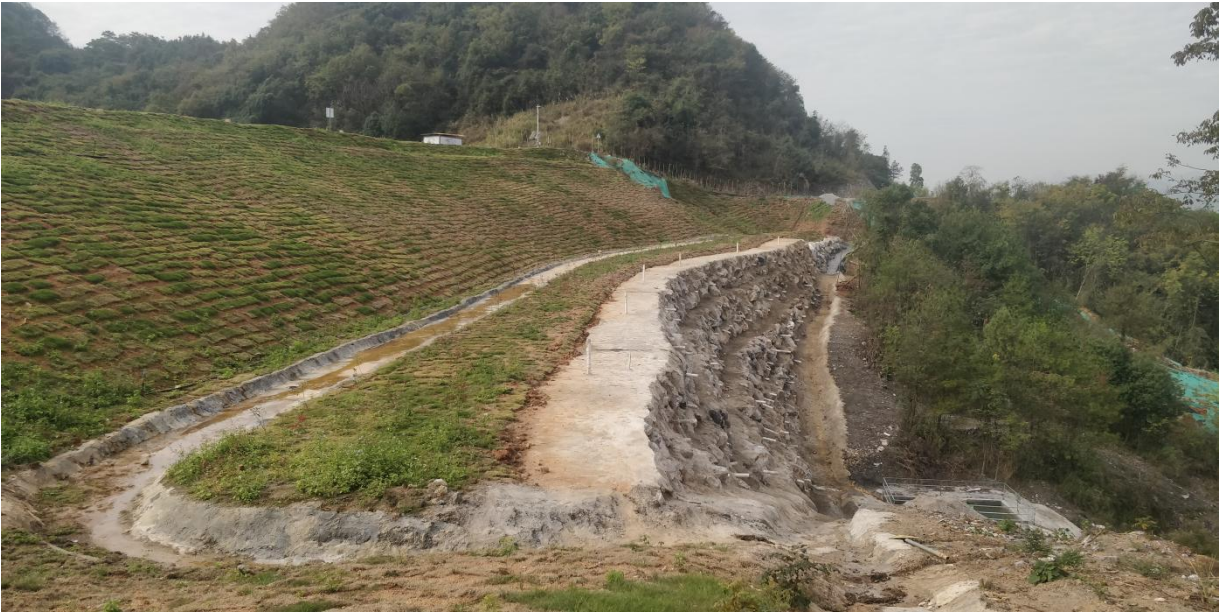
图 2.4-13 排土场挡土墙
