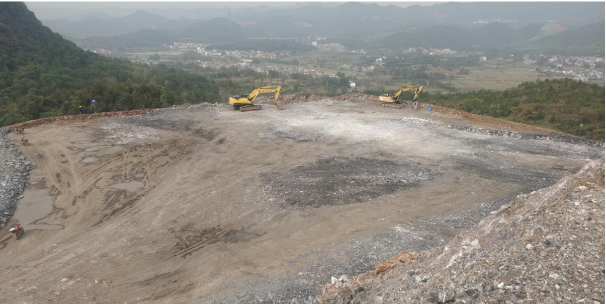
图 2.4-2 袁州区柏木乡布里村辖建筑用灰岩矿基建期采场现状图
