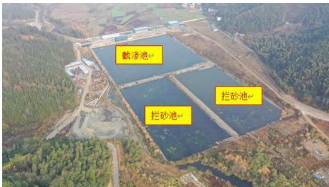
图 2-3 5 号库下游坝截渗池
