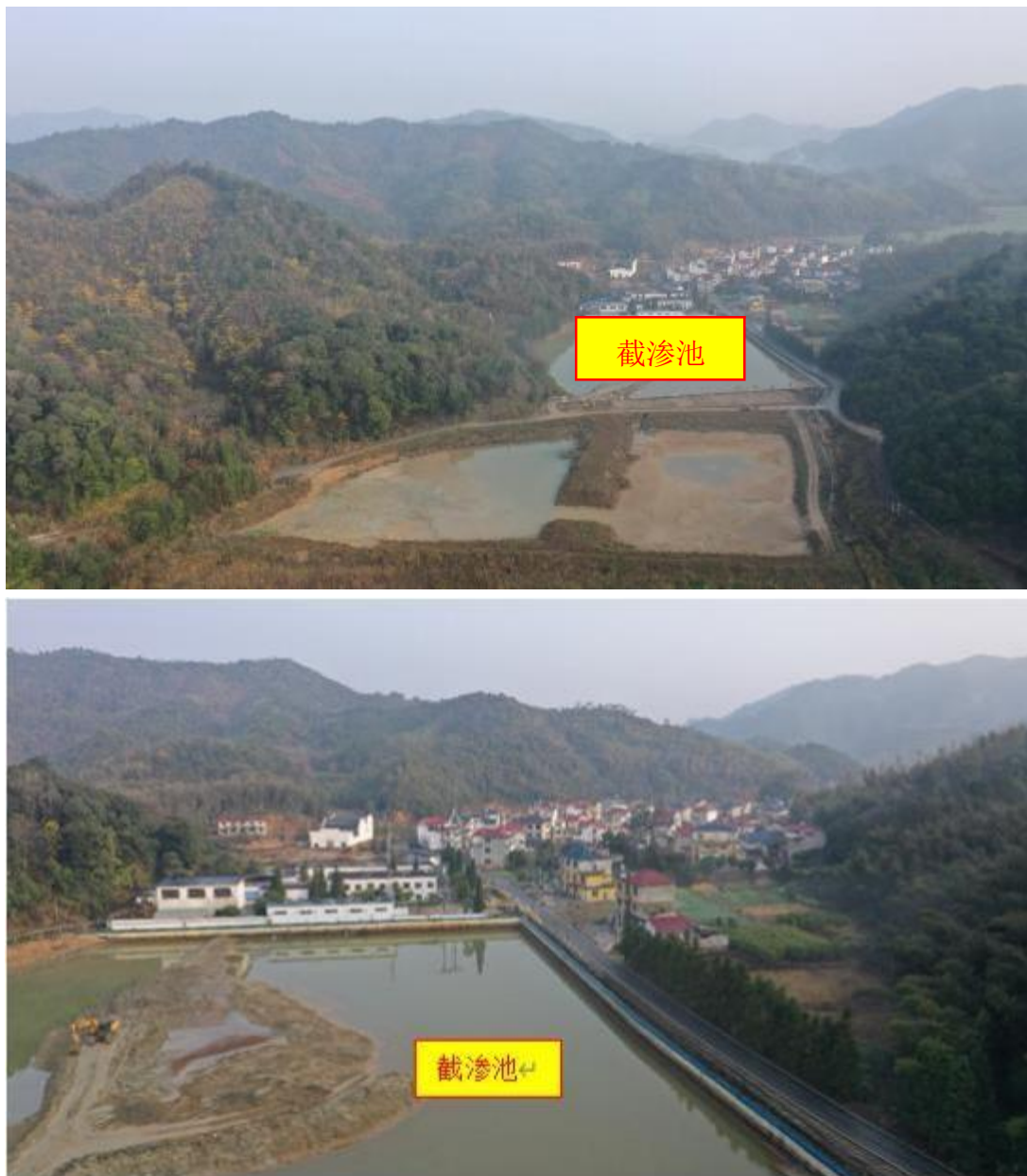
图 2-2 4#尾矿库截渗池现状
