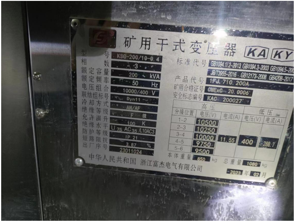
图 2-8 井下变压器
