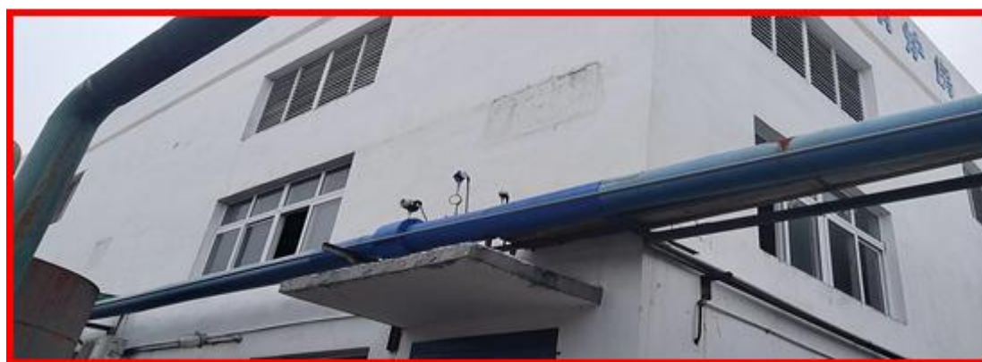
图 6.2.6-1 蒸汽总管上加装流量计
