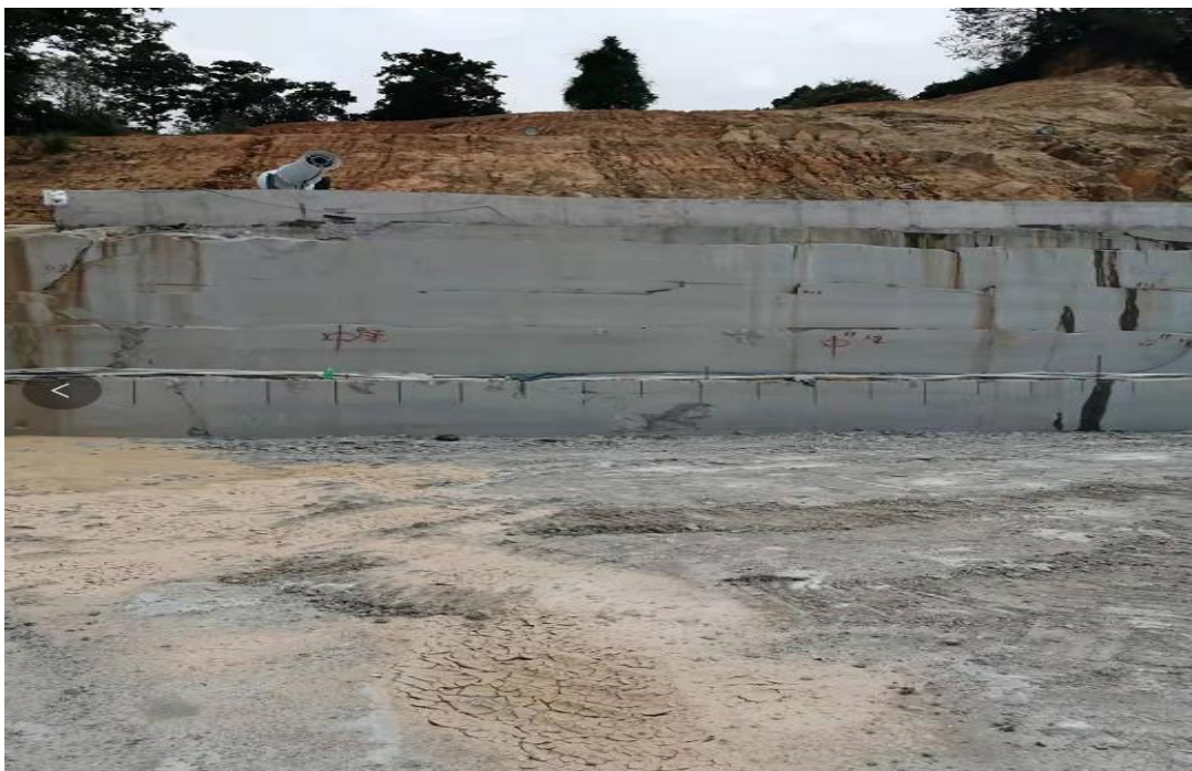
图 2.5-3 采场现场图片
