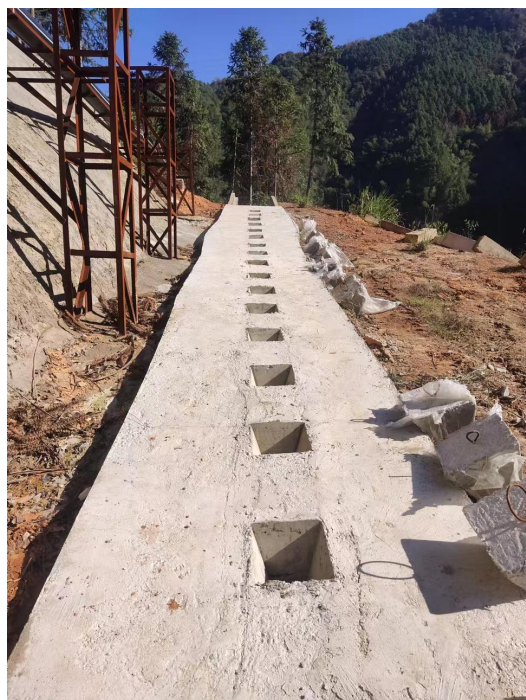
图 2-11 排水斜槽上部图
