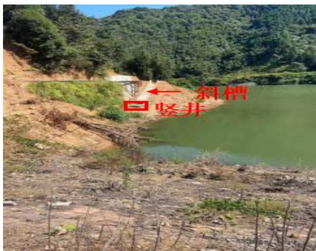
图 2-9 排水斜槽全景
