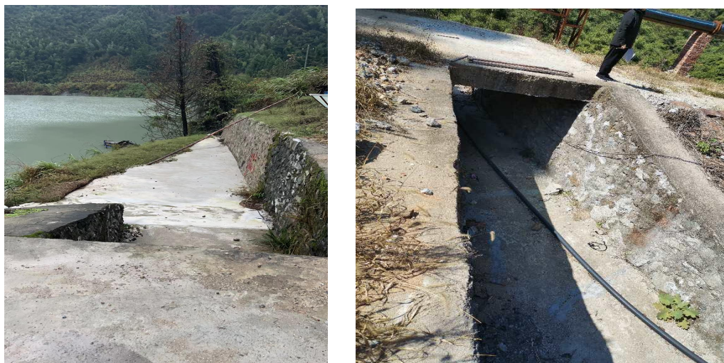
图 2-7 挡水副坝左坝肩正槽式溢洪道进口
