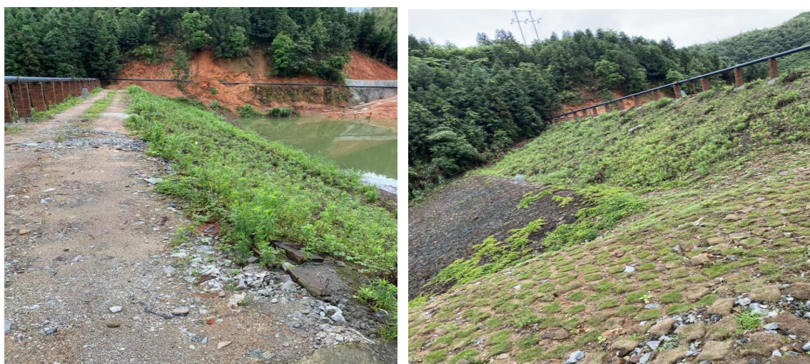
图 2-2 尾矿挡水副坝现场情况图
