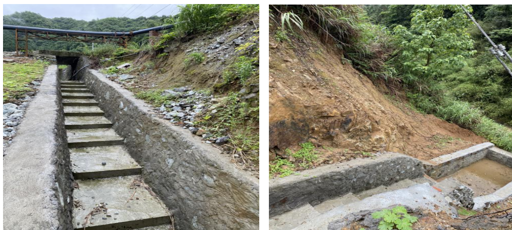
图 2-8 挡水副坝左坝肩正槽式溢洪道下游
