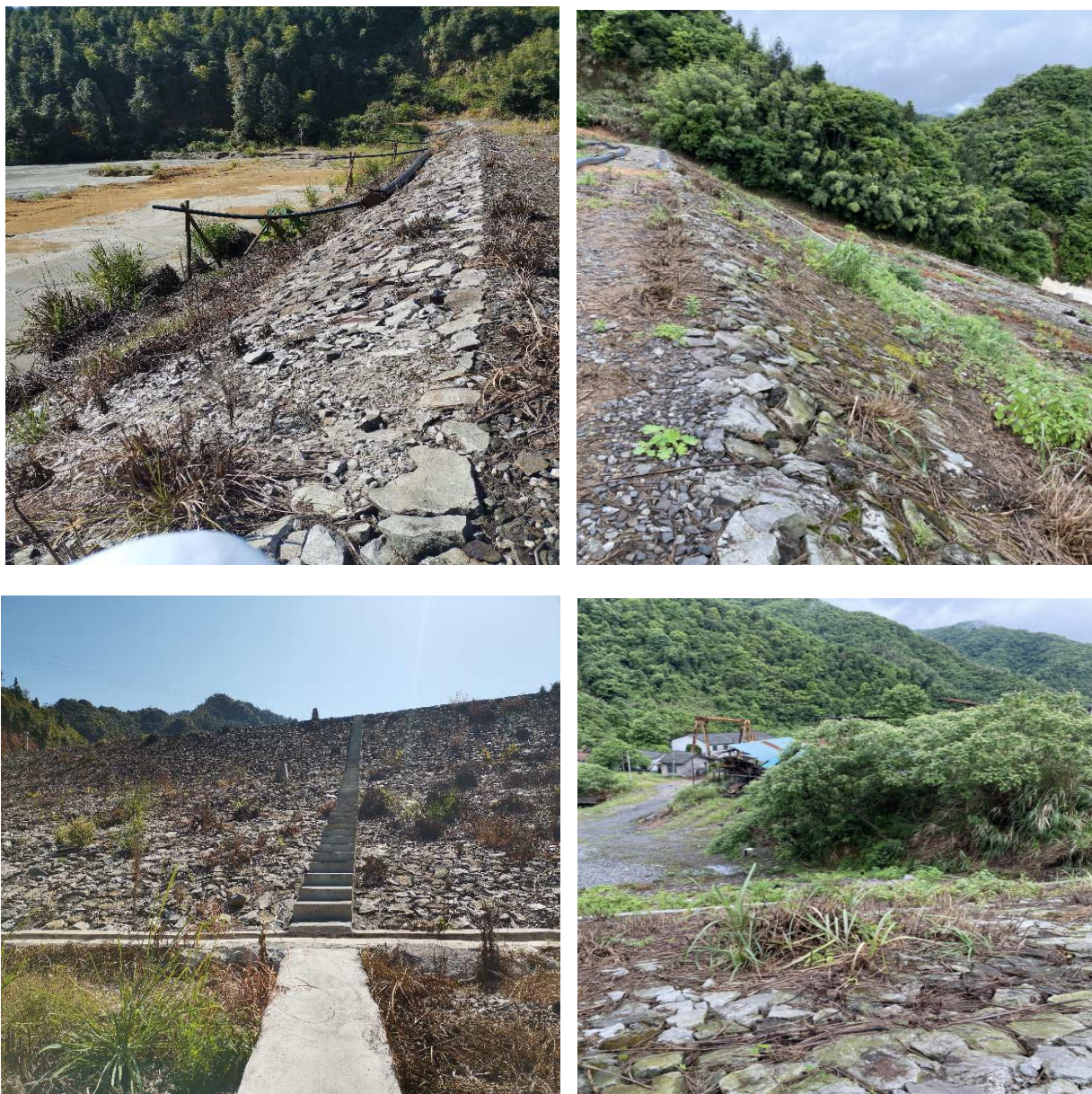
图 2-1 尾矿拦挡主坝现场情况图
