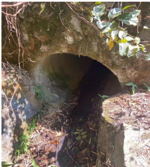
2-12 排水涵管出口
