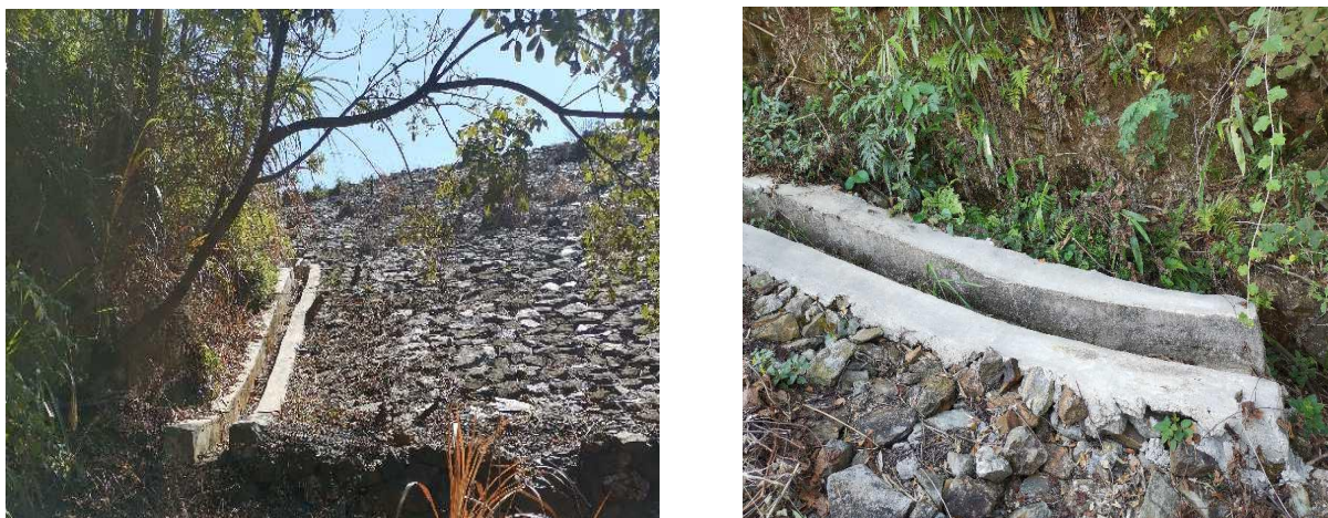
图 2-6 拦挡主坝坝面排水设施现场情况图（拦挡坝右坝肩排水沟、左坝肩排水沟）
