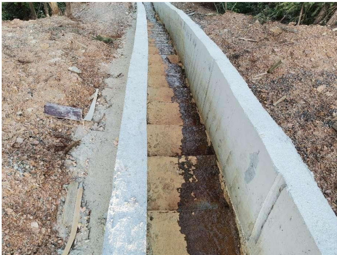
图 1 陡坡段消能坎
