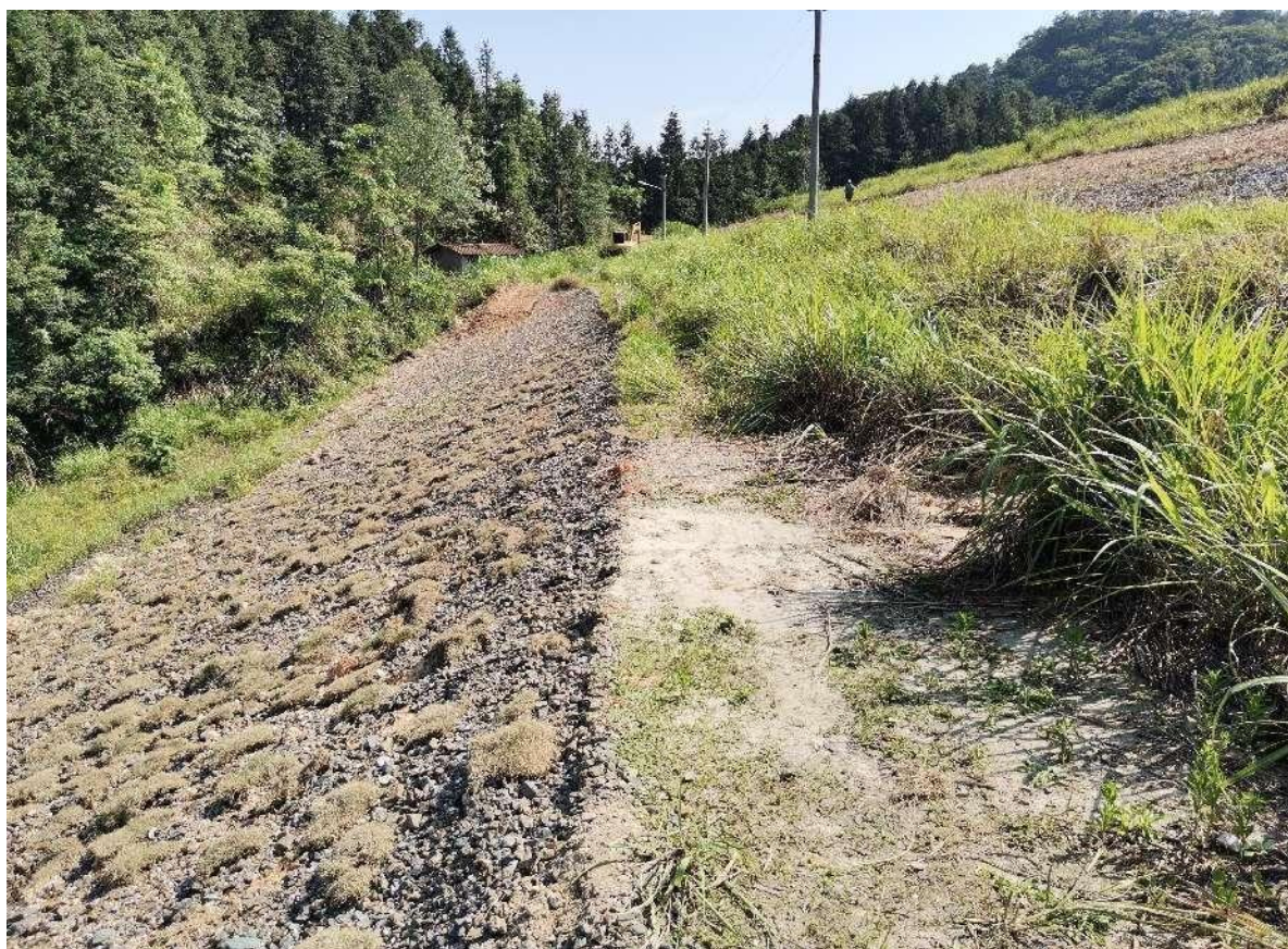
图 2 整治后马道和外坡植被（草皮）
