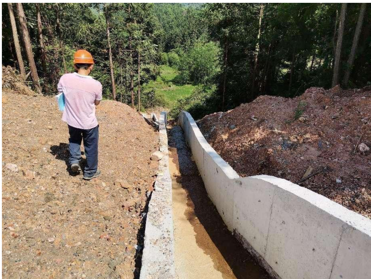
图 4 溢洪道陡坡段
