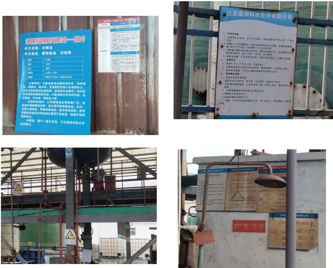
图 2.9.8-1 至 4 安全警示标志及危害告知牌
