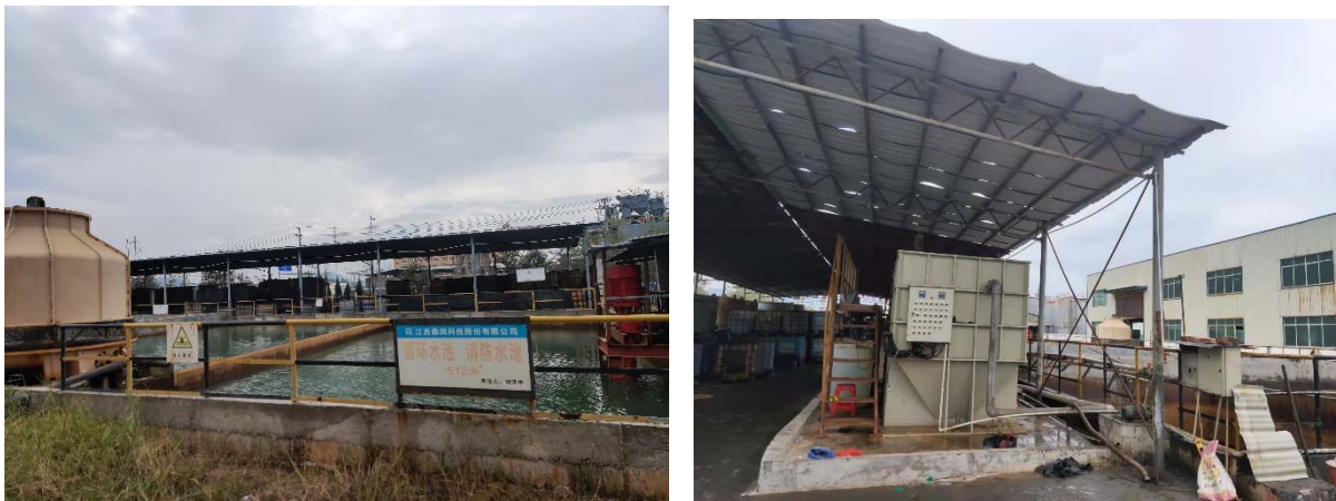
图 2.8.6-1 至 4 循环水池、消防水池 污水处理设施、污水处理池、事故池
