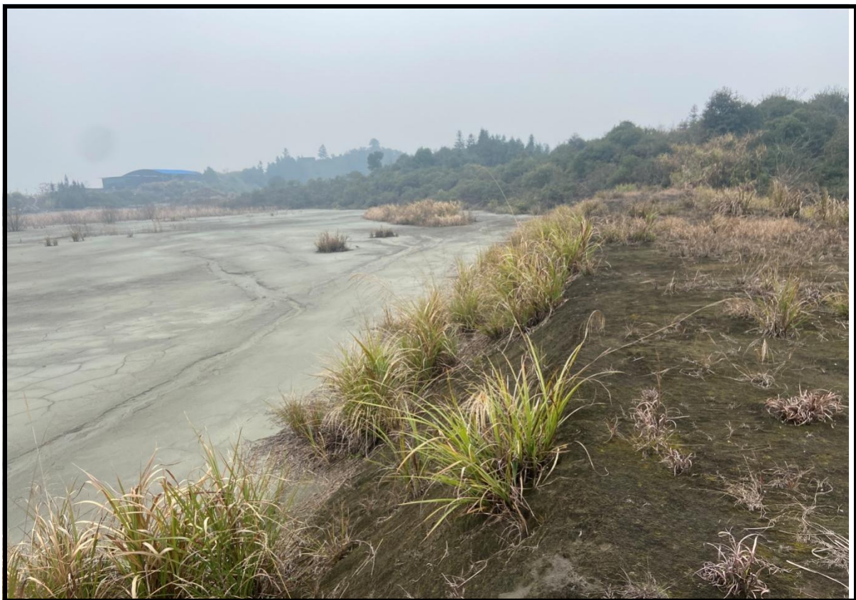
图 2-8 后期坝内坡现状图
