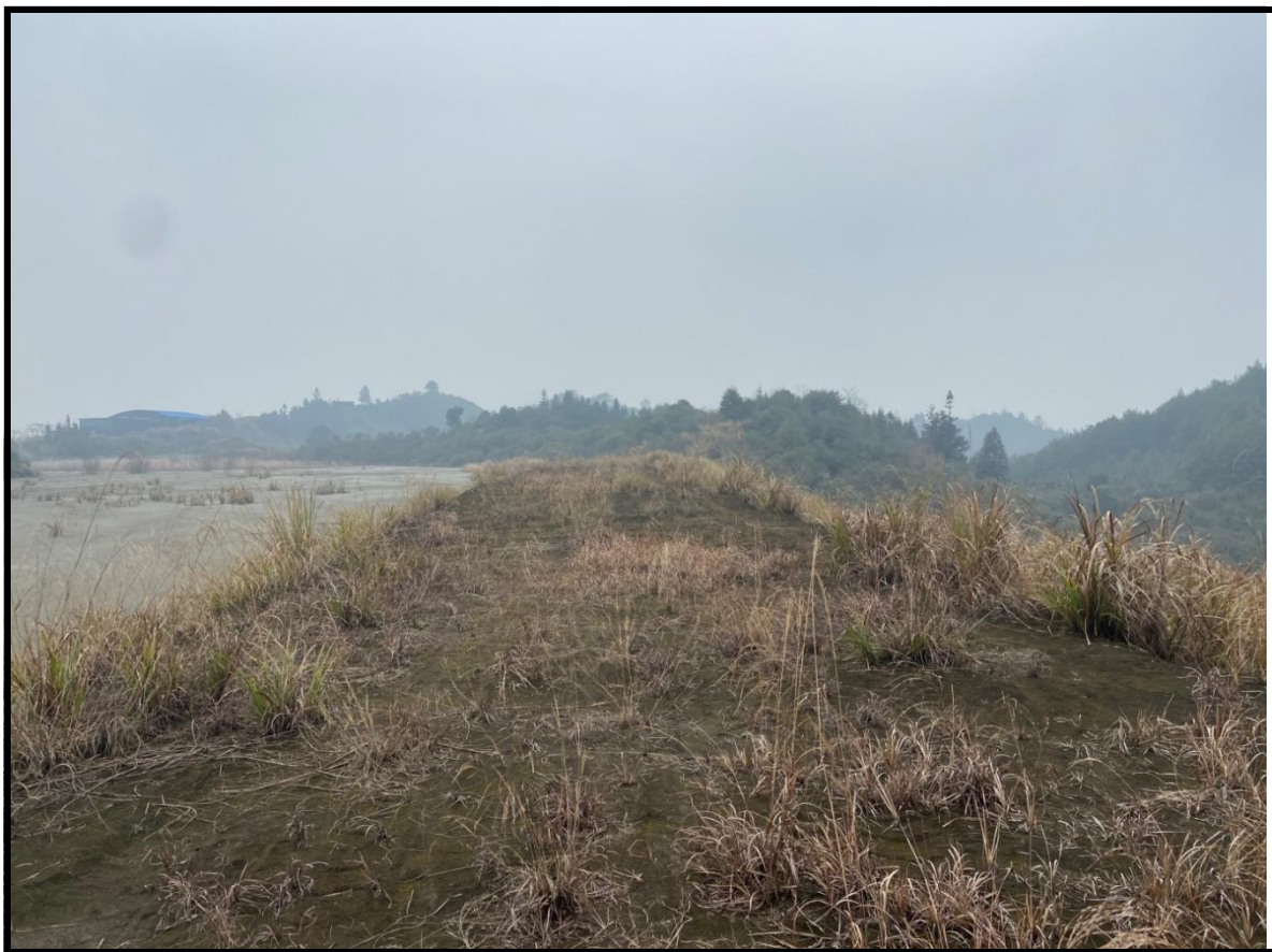
图 2-6 后期坝坝顶现状图
