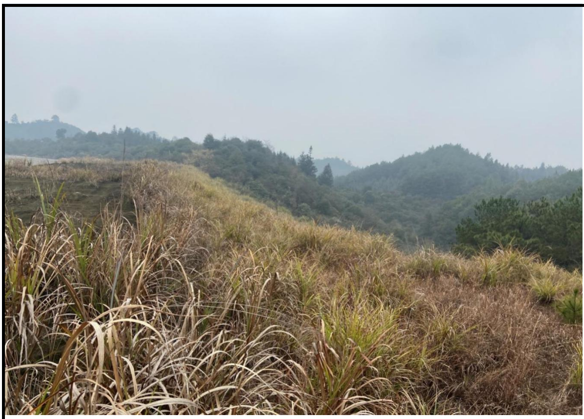
图 2-7 后期坝外坡现状图
