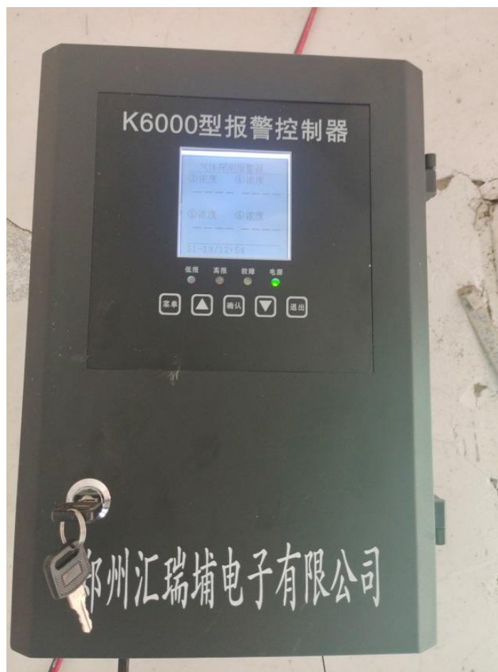
图 2.8-1 值班室可燃气体报警控制器
